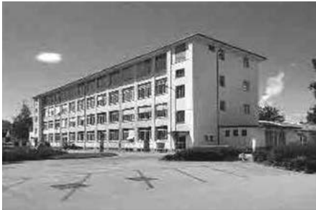
Ehemalige Stanzerei, reiner Betonskelettbau nach System Hannebique (1912) im Bally-.Areal
