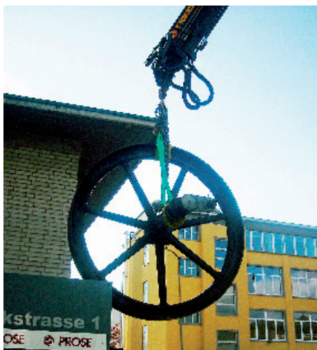
Das schwere Schwungrad schwebt an den Gurten.
