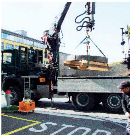
Die schwere Last wird auf den Lastwagen gehoben.
