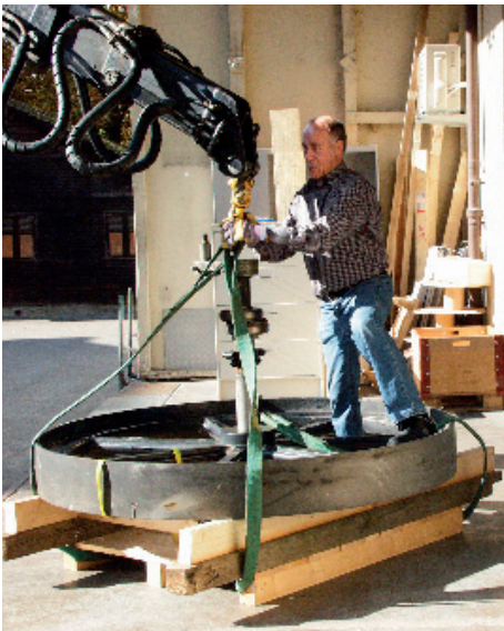
Alles ist gut in der Fabrikationshalle angekommen – die Gurten können gelöst werden.
