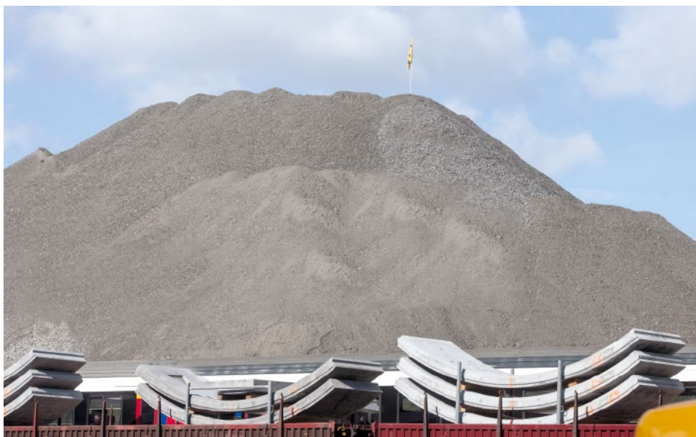
Zwischenlager des Tunnelausbruchmaterials mit Tübbing-Zug im Vordergrund.
