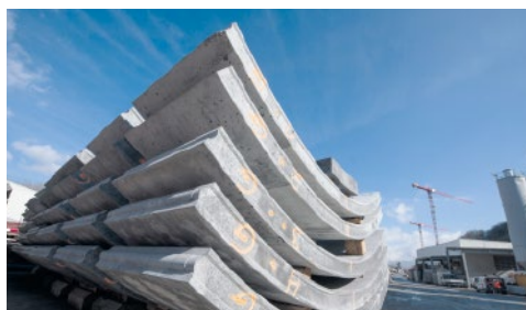
Tübbing-Lager auf der Eppenberger Baustelle.
