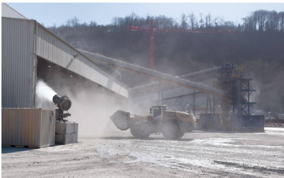
Abwurfhalle mit Ausbruchmaterial. Links im Bild ist eine der drei Schneekanonen zu sehen.
