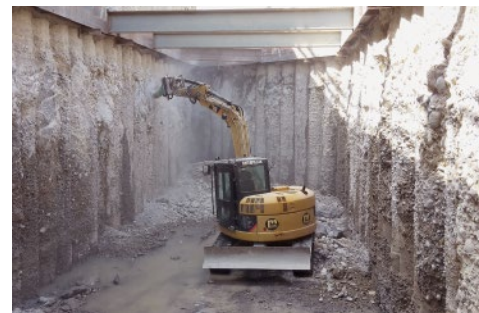
Die Grube ohne Wasser macht die Betonarbeiten des Tauchers sichtbar.
