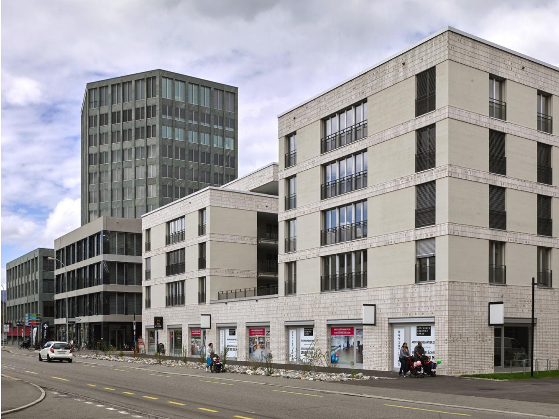
Wohnbau auf Gewerbesockel | Steib Gmür Geschwentner Kyburz Architekten, Aarau
