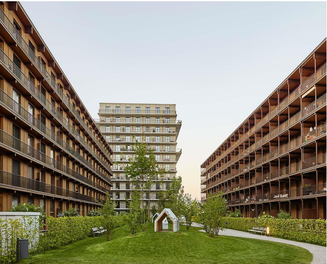
Balkonschicht und Freiraum | Rolf Mühlethaler, Zürich
