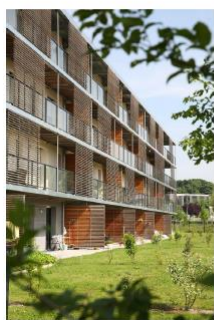
Gestaltung durchgehende Balkonschicht | Agency Goldfly Associates, Amiens
