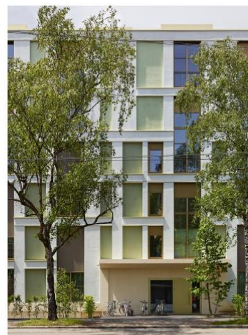
Strukturierte Fassadengestaltung | Duglex Architekten, Zürich
