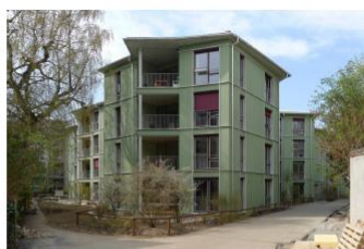
Strukturierte Fassadengestaltung | Jesenovec/Wendler, Basel
