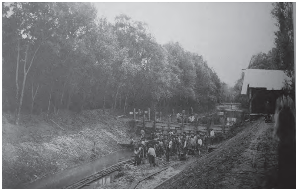
Fotografie von Arthur Bally, 1888: Verbreiterungs- und Vertiefungsarbeiten am Fabrikkanal (erbaut 1868/69). Die Wasserkraft-Turbine wurde mit einem Gleichstrom-Generator zur Stromerzeugung ausgestattet (Maschinenfabrik Oerlikon ZH).
