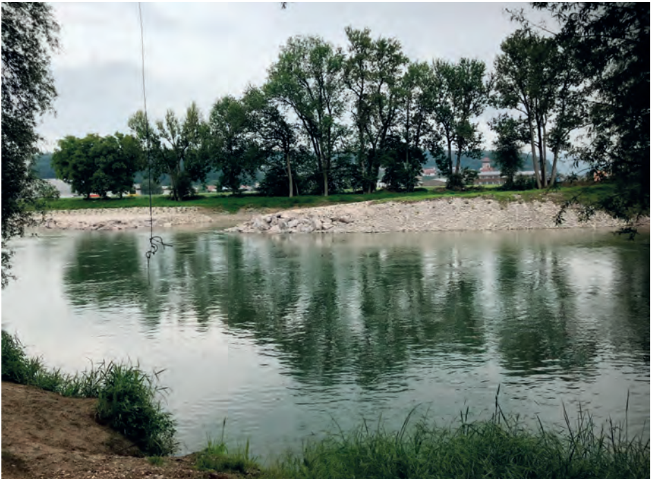
Neugestalteter alter Aarelauf zwischen Gretzenbach und Niedergösgen (Mai 2018).
