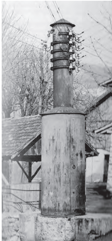
Die sinflutartigen Regenfälle im Juli 1898 brachten einen solchen «Transformatorenturm» in Schönenwerd zum Einsturz.
