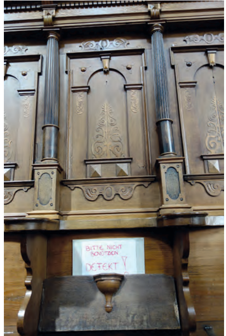
Renovationsbedürftiges Chorgestühl: «Bitte nicht benutzen. DEFECT!»
