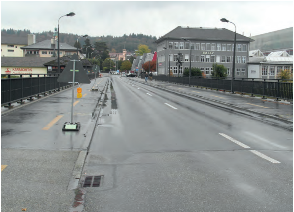
Die Brücke nach der Sanierung Ende der 1980er-Jahre (Bild Arno Oppliger).
