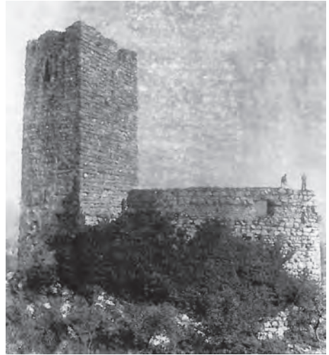
Burgruine Niedergösgen vor dem Abbruch 1902/03 (Denkmalpflege Solothurn).
